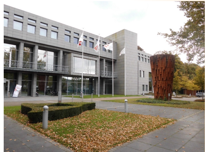
Provinciehuys Boeverbos: Dienst Vergunningen-Ruimtelijke Ordening in Brugge
